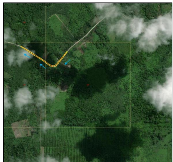
Gambar 4. Wilayah Pemetaan Kerusakan Jalan STA 23+000 – STA 23+620
