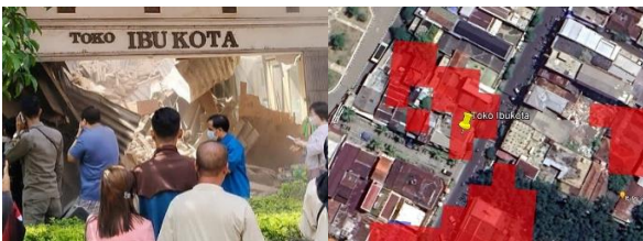
Gambar 5. Terdeteksi Kerusakan di Toko Ibu Kota
