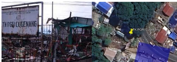
Gambar 6. Tidak Terdeteksi Kerusakan di TK PGRI Cugenang
